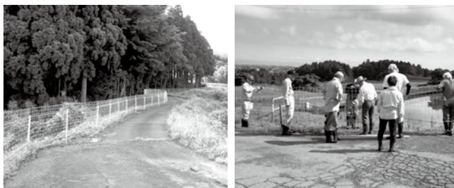
一 連代寺に設置された恒久柵
