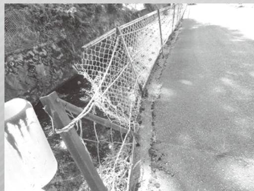
－沖地内中江川の転落防止柵－
